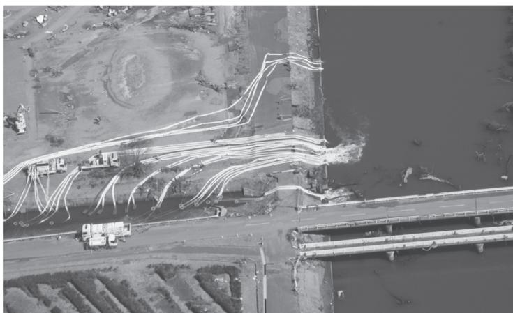
写真 緊急排水状況（3月24日）
